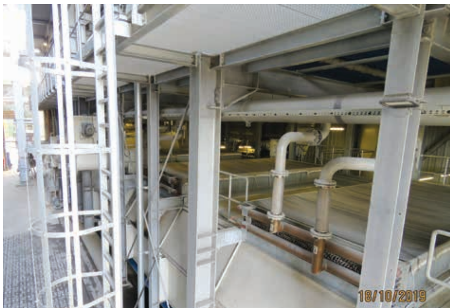
Suszarnia wysłodków wykorzystuje ciepło odpadowe z cukrowni
