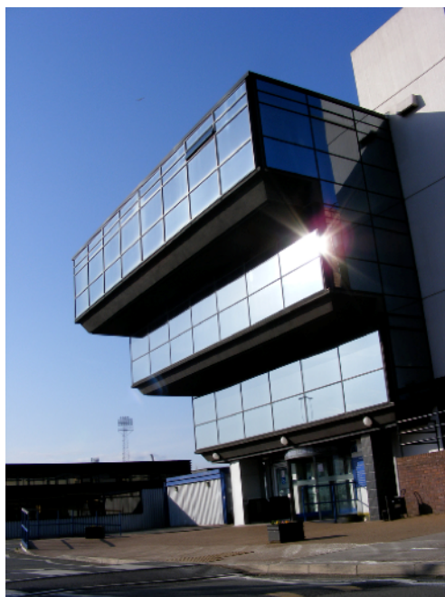
Fot. 1. Budynek Edward Llwyd Centre Fot. Jolanta Szczepaniak.
