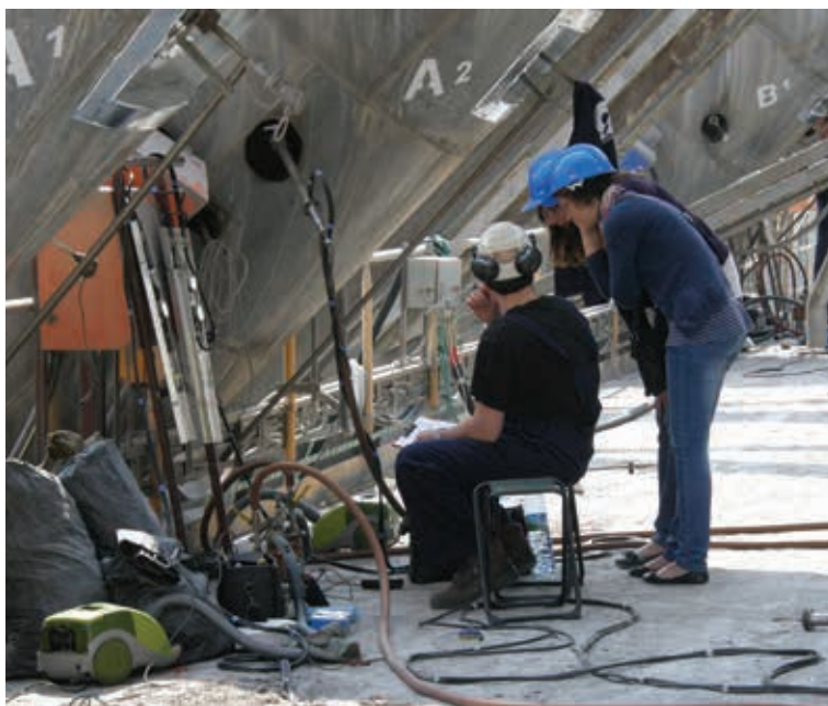
Cementownia „Warta” – kalibracja przyrządów pomiarowych na dachu elektrofiltrów
