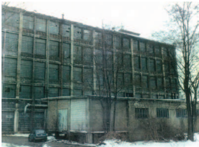
Budynek BPL przed remontem - 1997 r.
