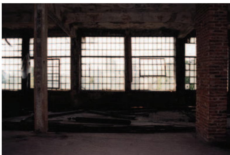
Wnętrze budynku w maju 1998 r.
