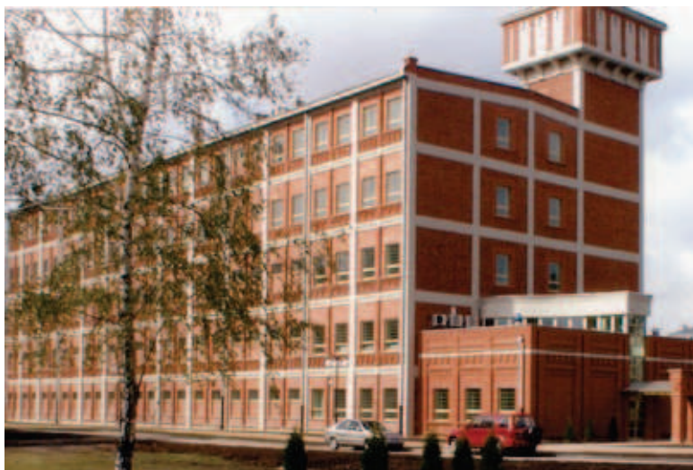
Budynek po remoncie w 2002 r.
