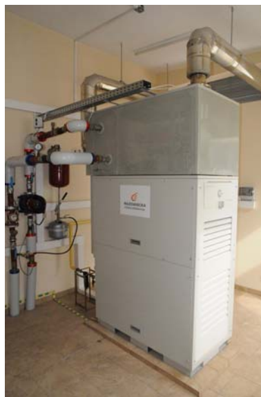
Rys. A. 1. Mikroturbina Capstone C30 zainstalowana w Laboratorium Generacji Rozproszonej Politechniki Łódzkiej
