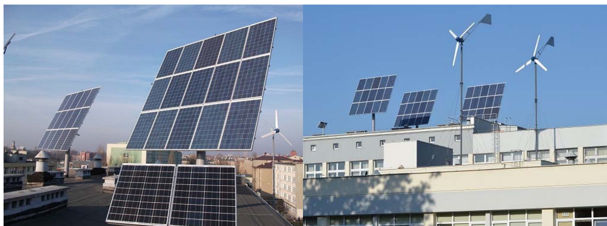
Rys. A. 6. Widok paneli fotowoltaicznych nadążnego systemu fotowoltaicznego Źródło: opracowanie własne.
