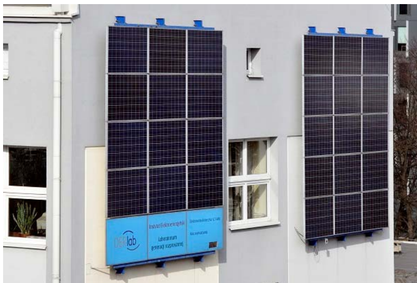
Rys. A. 7. Widok paneli fotowoltaicznych stacjonarnego systemu fotowoltaicznego Źródło: opracowanie własne.
