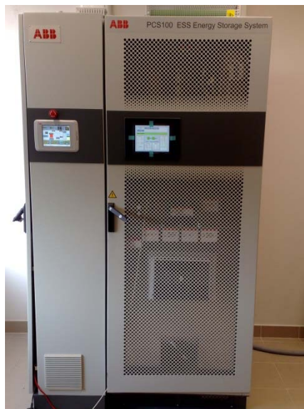
Rys. A. 5. Układ PCS 100 ESS firmy ABB zainstalowany w Laboratorium Generacji Rozproszonej Politechniki Łódzkiej
