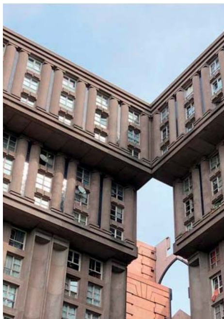
Ryc. 9. Les Espaces d' Abraxas, widok na narożnik pałacu Fotografie autorów 2019.
