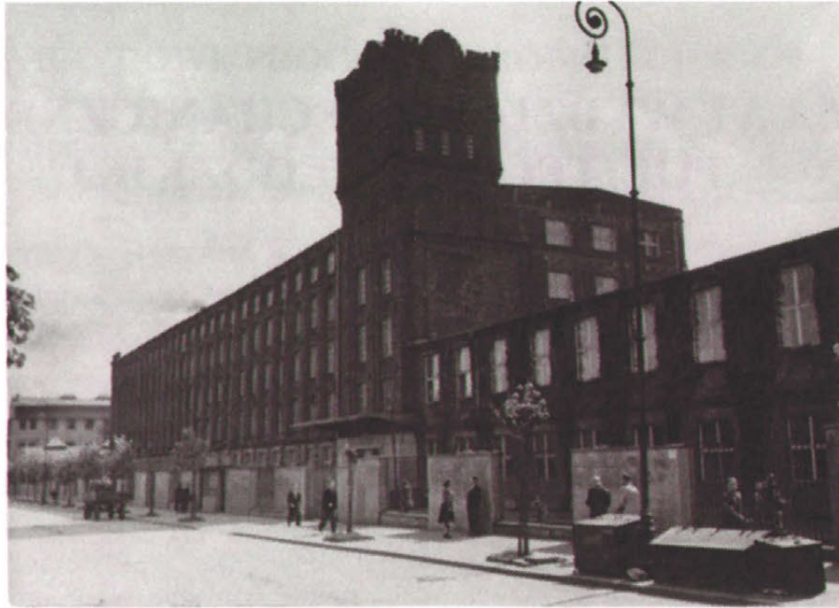
Rys. 1. Pawilon Główny, ul. Gdańska, 1948 rok ( Budynek główny fabryki Rosenblatta )
