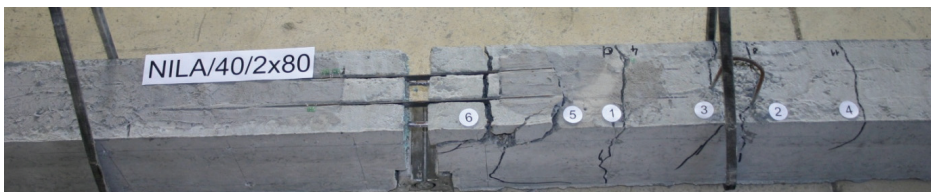
Rys. 5.24. Układ rys w belce NILA/50/2x80 (widoki z góry) Fig. 5.24. Cracking pattern in beam NILA/50/2x80 (top view)
