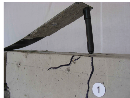
Rys. 5.6. Typ zniszczenia „D” (zewnętrzna taśma) Fig. 5.6. Failure mode „D” (externally bonded strip)
