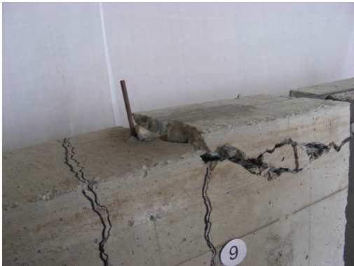
Rys. 5.3. Typ zniszczenia B (pojedyncza wklejona taśma) Fig. 5.3. Failure mode „B” (single NSM strip)
