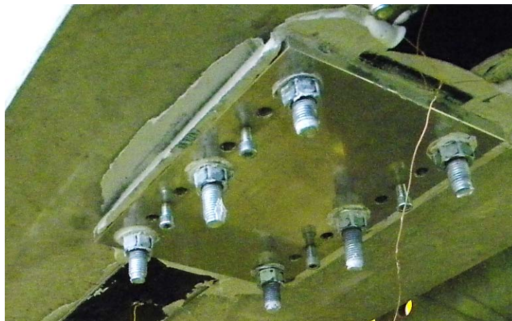
Rys. 2.17. Blacha kotwiąca pozostała docelowo w miejscu zakotwienia naprężonej taśmy
