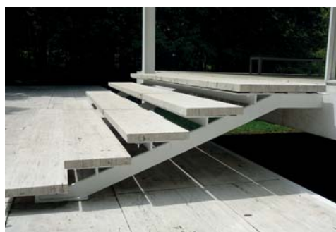
Ryc. 6. (z prawej): Detal płyt tarasowych. Fot. autora
