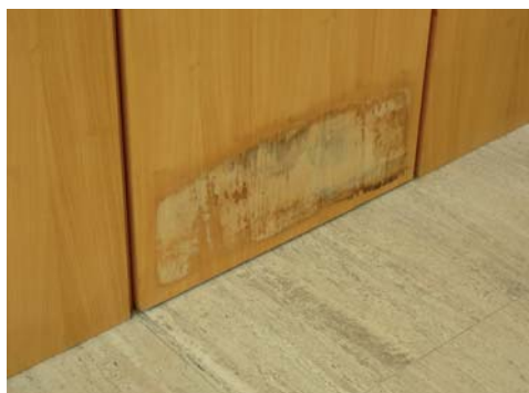
Ryc. 10. Ślady korozji elementów stalowych we wnętrzu
