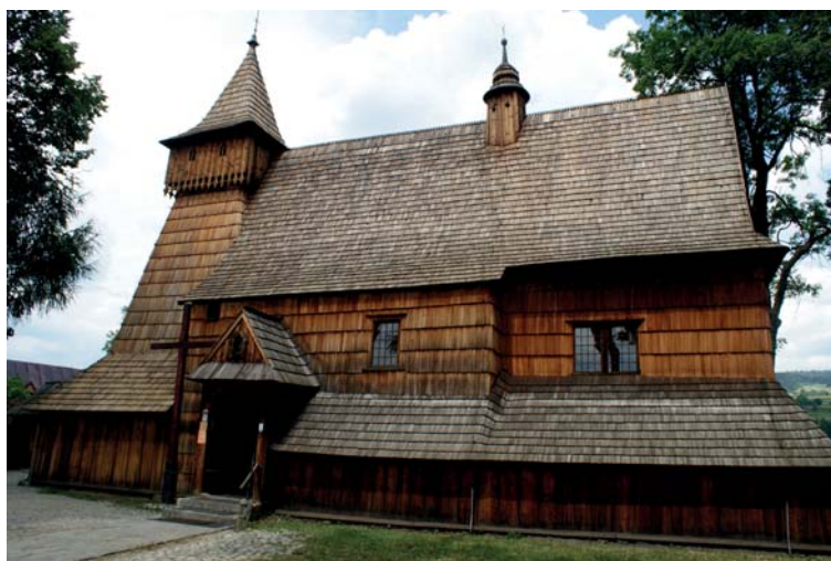
Ryc. 1. Kościół pw. św. Michała Archanioła w Dębnie (2015). Fot. autorki
