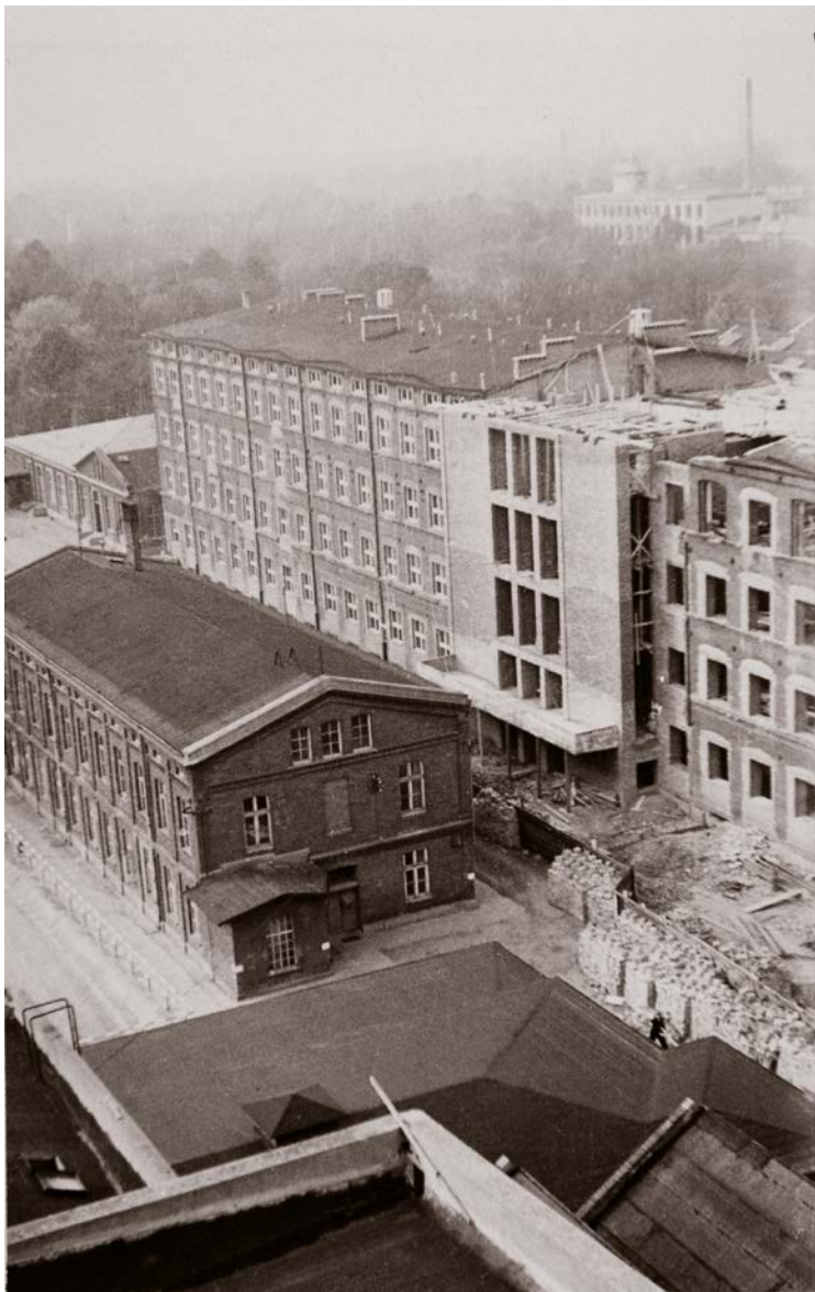
Politechnika Łódzka. Widok na remontowany gmach Wydziału Chemicznego. 1948-1949
