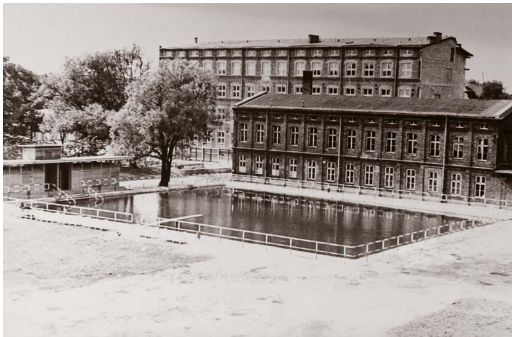
Widok na budynek stołówek, w głębi remontowany budynek Wydziału Chemicznego
