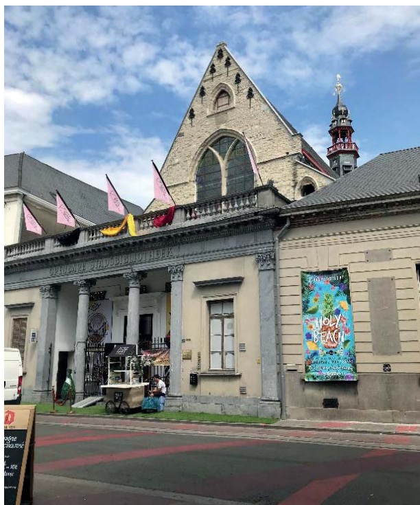
Ryc. 3. Widok na główne wejście do foodcourtu. Tuż nad nim uidać napis OPENBARE STADSBIBLIOTHEK– pozostałość po dawnej bibliotece
