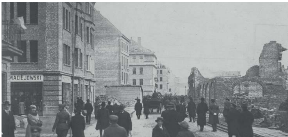
Ryc. 1. Widok ul. Śródmiejskiej w Kaliszu w stronę Głównego Rynku. Nowe kamienice kontrastują z ruinami pozostałymi po I wojnie światowej
