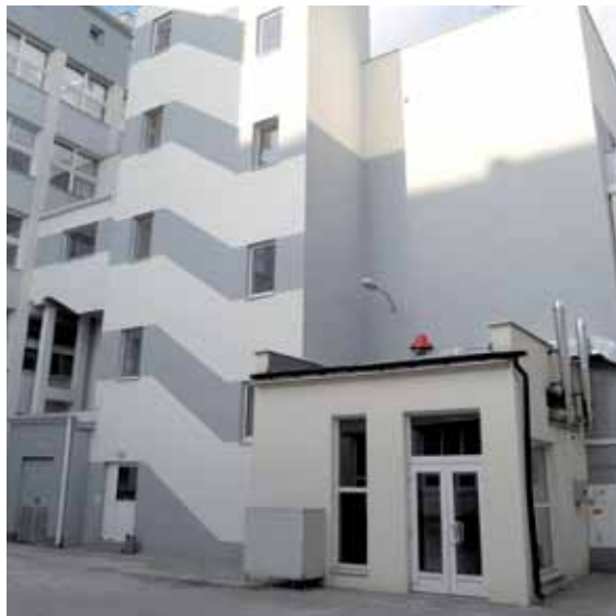
Klatka schodowa z łącznikiem
