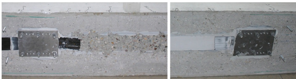
Rys. 7. Widok spodu belki P3 po zniszczeniu (lewa – zakotwienie czynne, prawa – zakotwienie biernie) Fig. 7. View of the bottom side of the beam P3 after failure (left – active, right – non-active anchorage)
