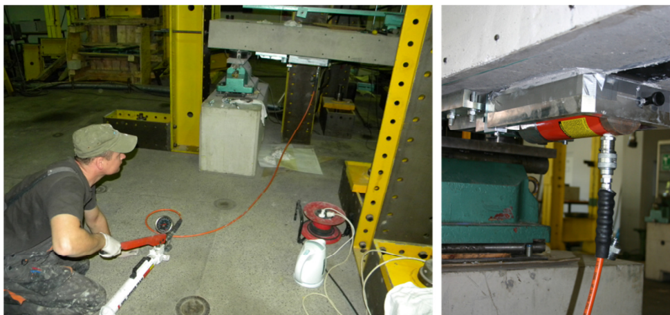
Rys. 6. Naprężanie taśm Fig. 6. Prestressing CFRP laminates
