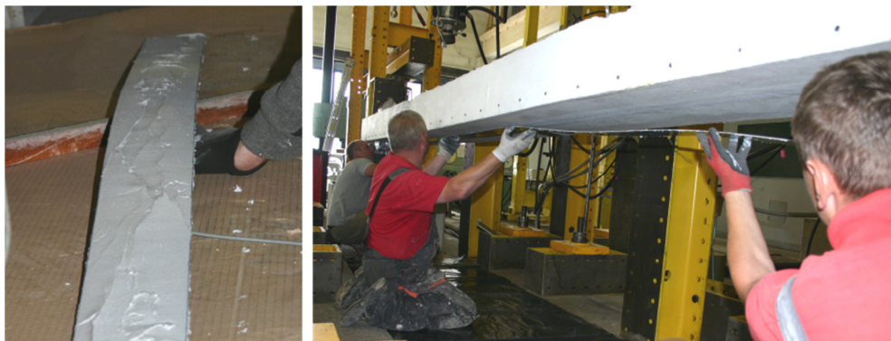
Rys. 5. Przyklejanie taśmy na powierzchni belki Fig. 5. Laminate bonding to the concrete surface
