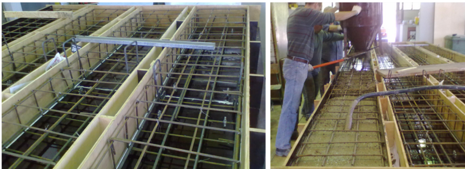
Rys. 3. Szkielety zbrojeniowe (lewe), betonowanie belek (prawe) Fig. 3. Steel reinforcement (left) and concreting process (right)
