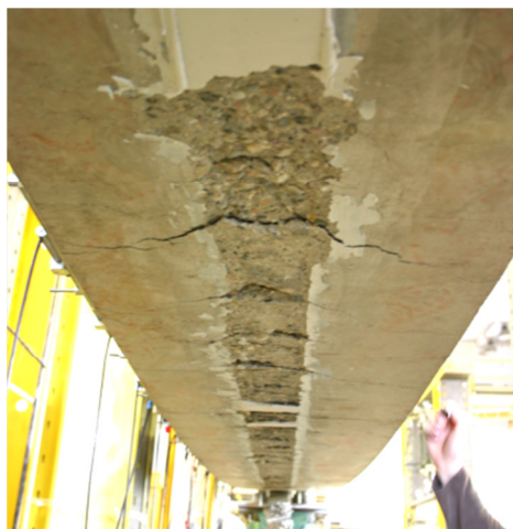
Rys. 8. Widok spodu belki P7 z układem rys po odspojeniu kompozytu Fig. 8. View of the bottom side of the P7 beam concrete cover cracking
