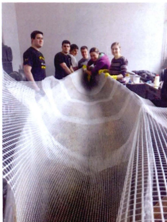
Fot. 3. Nakładanie siatki podłogowej z włókna szklanego
