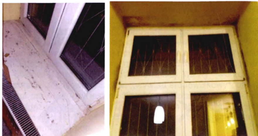
Rys. 8. Stan parapetów i okien
