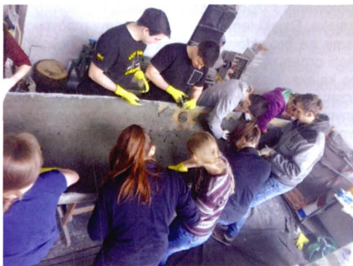
Fot. 4. Nakładanie pierwszej warstwy betonu
