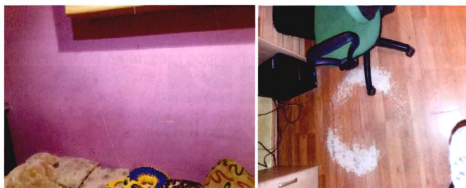
Rys. 9. Stan ścian i podłóg
