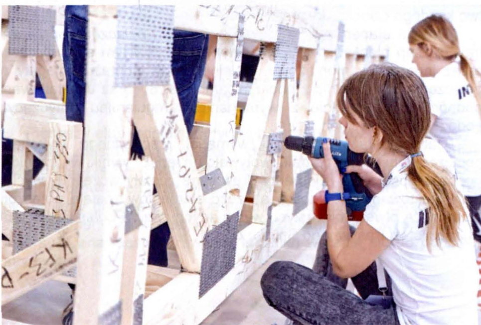
Rys. 9. Wykonywanie połączeń poprzecznic z podłużnicą drużyny WANNK
