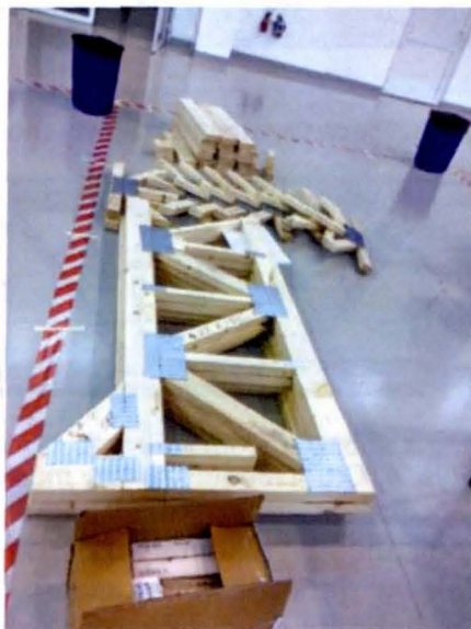
Rys. 6. Elementy konstrukcyjne przed rozpoczęciem montażu
