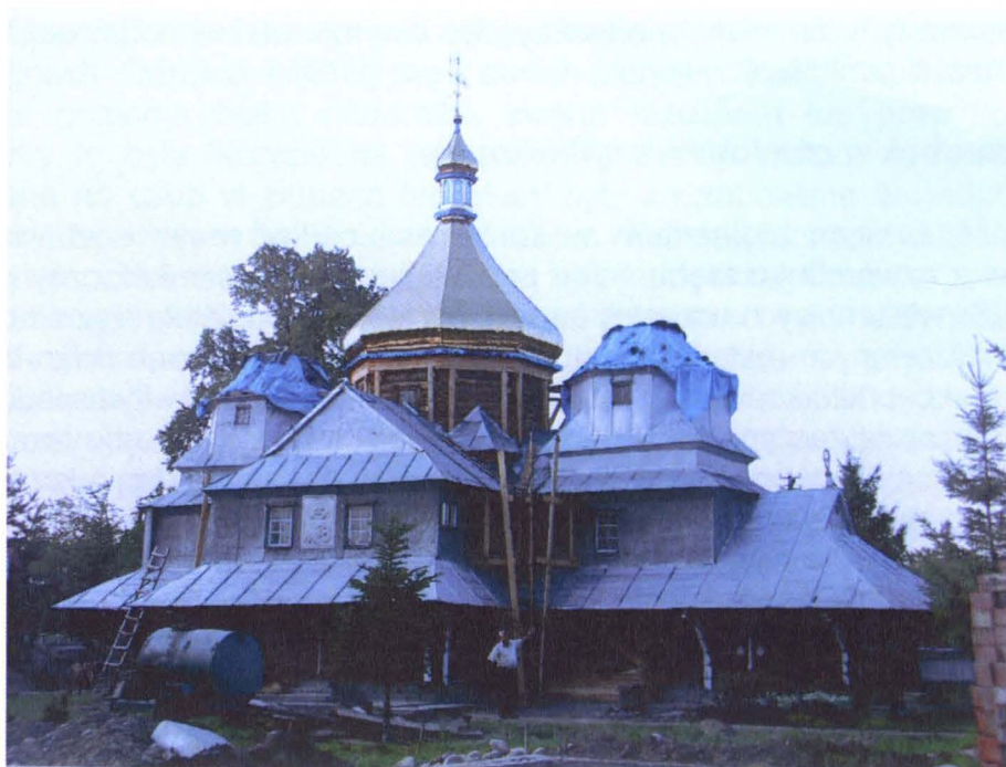
Ryc. 9. Cerkiew w Zamulińcach w trakcie wymiany dachówki nad kopułami Fot. Mykołaj Stryżakows'kij, reprodukcja: Włodzimierz Witkowski
