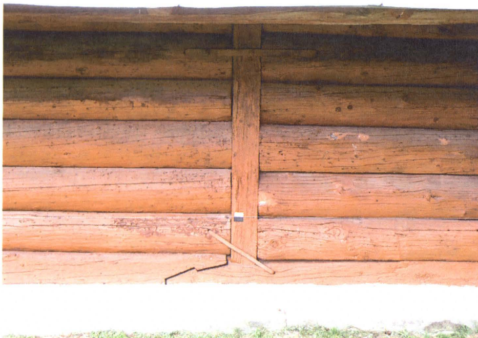
Ryc. 5. Podwalina i ściana wieńcowa – sposób przedłużania, Cerkiew w Kazanowie Fot. Włodzimierz Witkowski
