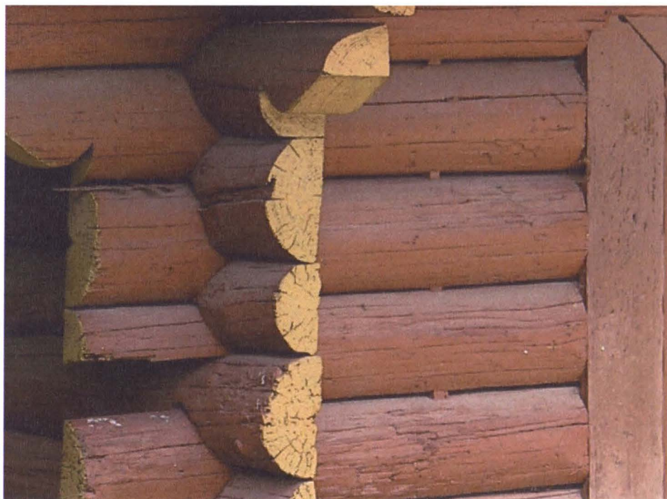
Ryc. 7. Połączenie bali za pomocą tybla, Cerkiew w Trościańcu Fot. Włodzimierz Witkowski
