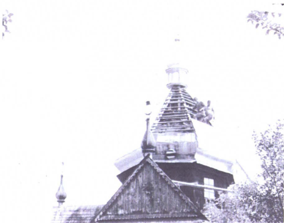
Ryc. 10. Cerkiew w Luczkach w trakcie wymiany pokrycia dachu nad kopułą Fot. archiw. (lata 60. XX w.), zbiory prywatne, reprodukcja: Włodzimierz Witkowski
