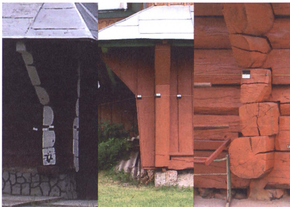
Ryc. 3. Typy fundamentów. Od lewej: na kamieniach – Cerkiew w Zamulińcach, wyprawa 2013, na kamieniu – Cerkiew w Słobdzie, wyprawa 2011, na pału drewnianym – np. Cerkiew w Woronie, wyprawa 2011 Fot. Piotr Szybalski
