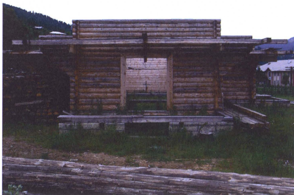
Ryc. 4. Przewietrzanie fundamentów. Nowa Cerkiew w Stebniach nad Białym Czeremoszem Fot. Włodzimierz Witkowski
