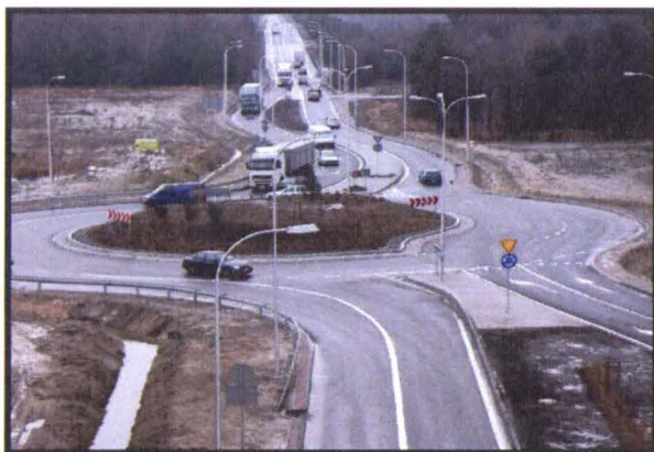
Rys. 4. Separatory ruchu na turborondzie typu polskiego [S2]
