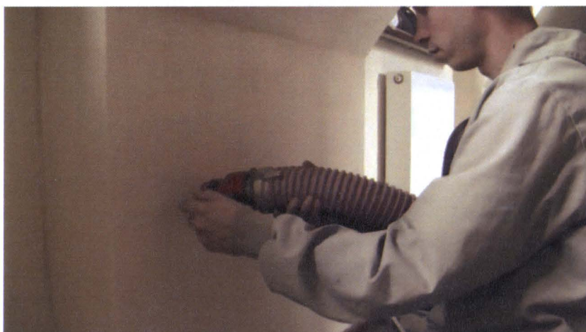
Rys. 7. Wdmuchiwanie celulozy w przestrzeń ścianki kolankowej; fot. DEROWERK
