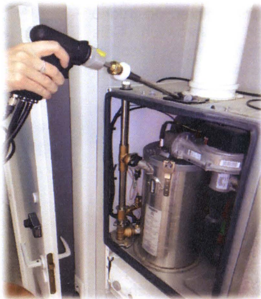
Rys. 10. Sonda pomiarowa umieszczona w kanale spalinowym
