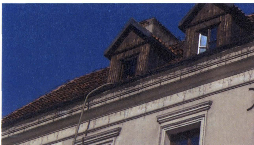
Rys. 4. Wąż podający materiał izolacyjny na ostatnią kondygnację budynku; fot. DEROWERK
