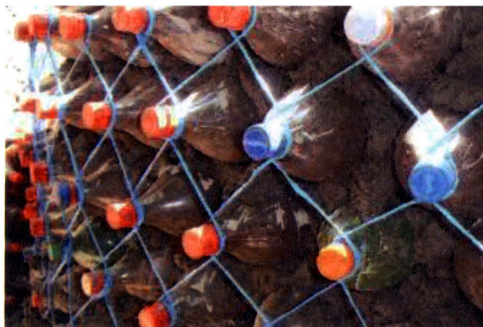
Rys. 6. Budowa ściany z użyciem nylonowej nici [5]
