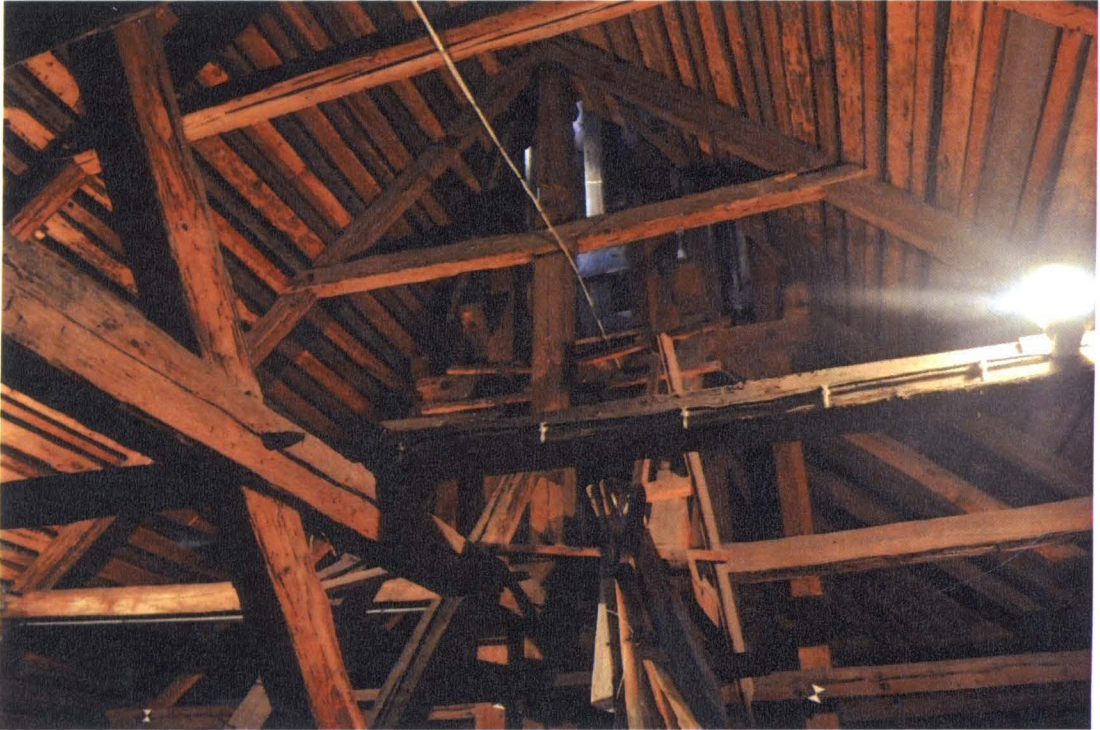
Rys. 12. Kościół pw. św. Wojciecha w Niesułkowie – widok więźby dachowej. Fot. Mateusz Przybylski
