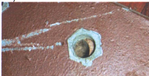
Rys.2. Przemieszczenie łuku w okuciu po wyjęciu śrub montażowych
