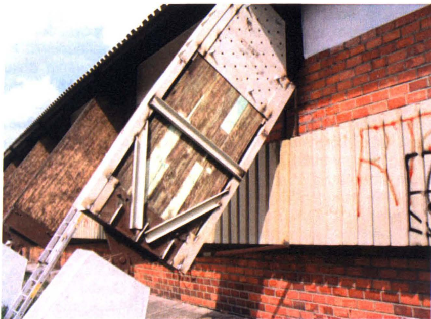
Rys.7. Dodatkowe zabezpieczenie podpory dźwigara
