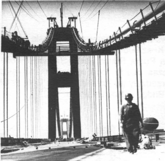
Rys. 2. Budowa mostu – 1940 r. [1]
