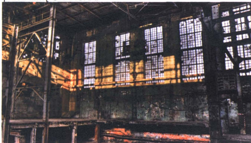
Rys. 1. Budynek rozdzielni – stan istniejący [2]
