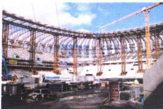
Rys. 6. Montaż części fasadowej konstrukcji stalowej
