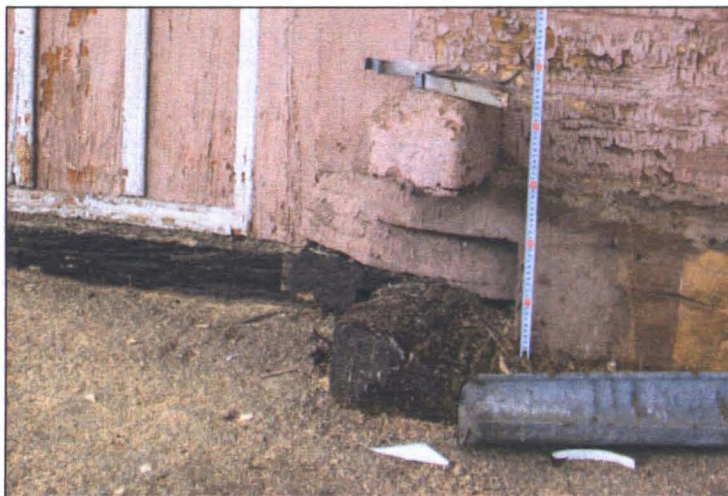
Rys. 7. Tyśmienica- drewniana podwalina częściowo zalana betonem (fot. Piotr Szybilski)
