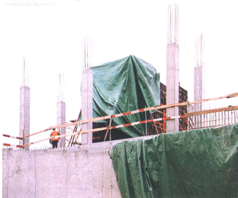
Rys.7 Okrywanie betonu przed mrozem
