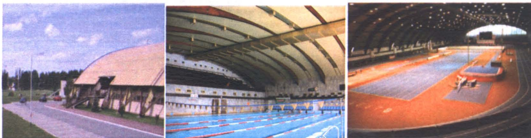
Rys.1. Badane hale sportowe: a) Hala w Zgierzu, b) Hala basenu w Spale, c) Hala sportowo-widowiskowa w Spale
