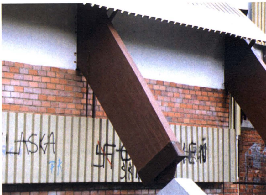
Rys.8. Widok dźwigara po naprawie
