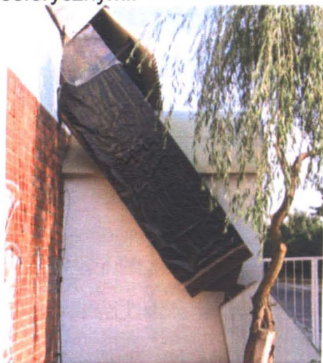
Rys.5. Dźwigar przygotowany do dezynsekcji metodą gazowania
