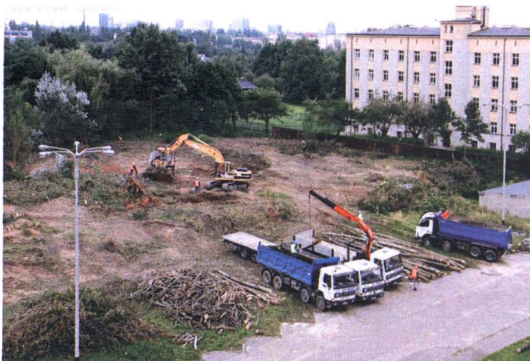
Rys.4 Przygotowanie terenu pod budowę
