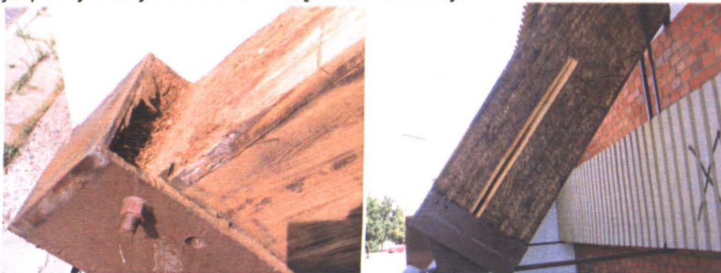
Rys.6. Dźwigary przygotowane do naprawy
