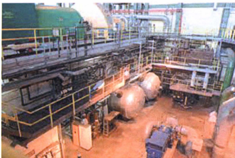
Rys. 2. Maszynownia, serce elektrociepłowni
