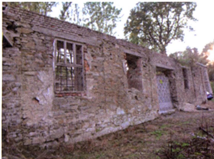
Rys.12. Cerkiew w Płonnej. Widok elewacji północnej. 2009 rok (fot. M. Białko)
