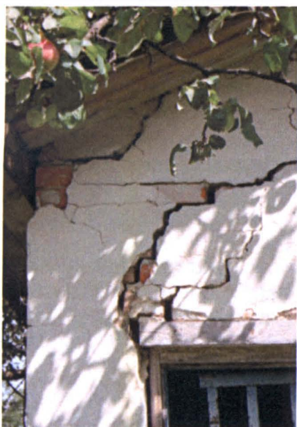
Rys. 12. Przybudówka od strony północnej
