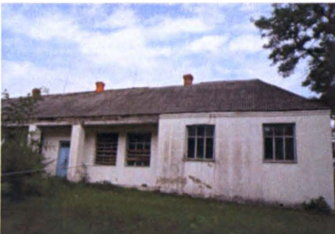
Rys. 3. Widok elewacji południowej
