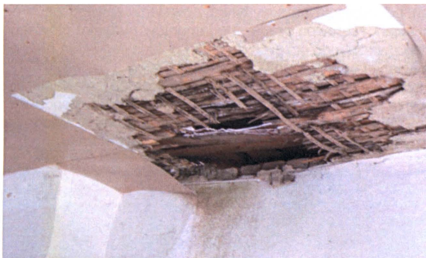
Rys. 11. Odkrywka stropu
