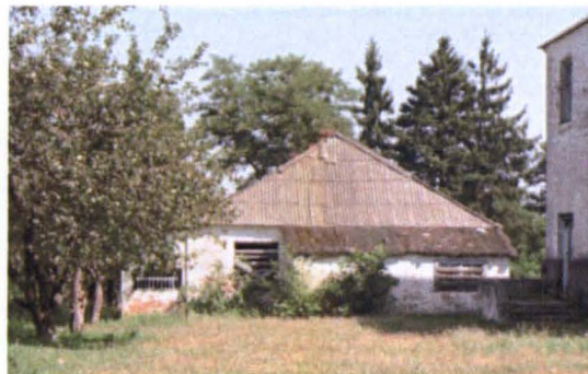
Rys. 4. Widok elewacji zachodniej
