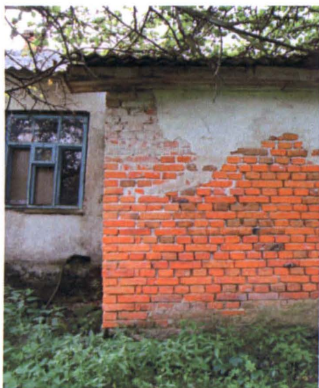
Rys. 14. Odpadnięcie tynku
