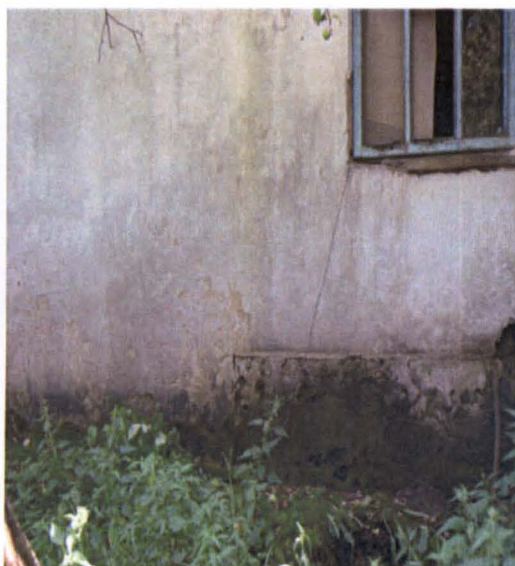
Rys.15. Zawilgocenie fundamentów
