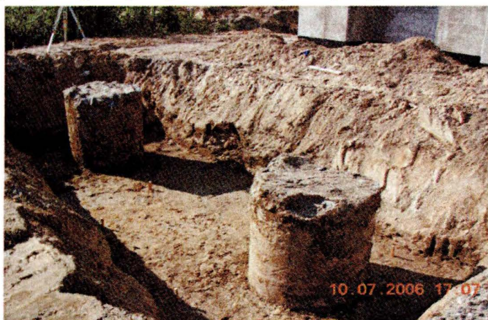
Rys.4. Pale fundamentowe pod ławę podpory tymczasowej
