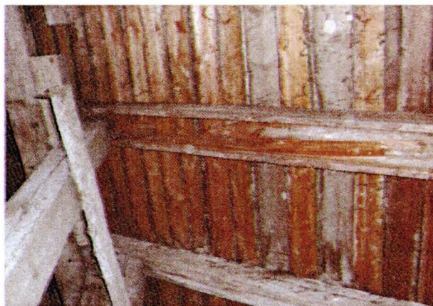
Rys.3 Uszkodzona krokiew „obalowana”
