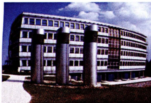
Rys. 5. EnerGon. z przodu czerpnie powietrza (fot. Projekt Real Estate Frankfurt GmbH)
