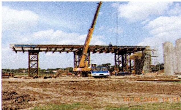
Rys.7. Budowa stanowiska nasuwczego
