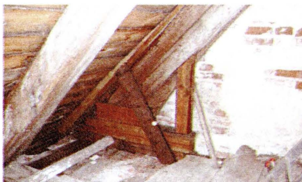
Rys.4 Uszkodzony szczytowy wiązar
