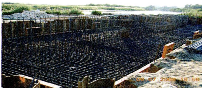
Rys.5. Zbrojenie ławy fundamentowej przyczółka mostowego
