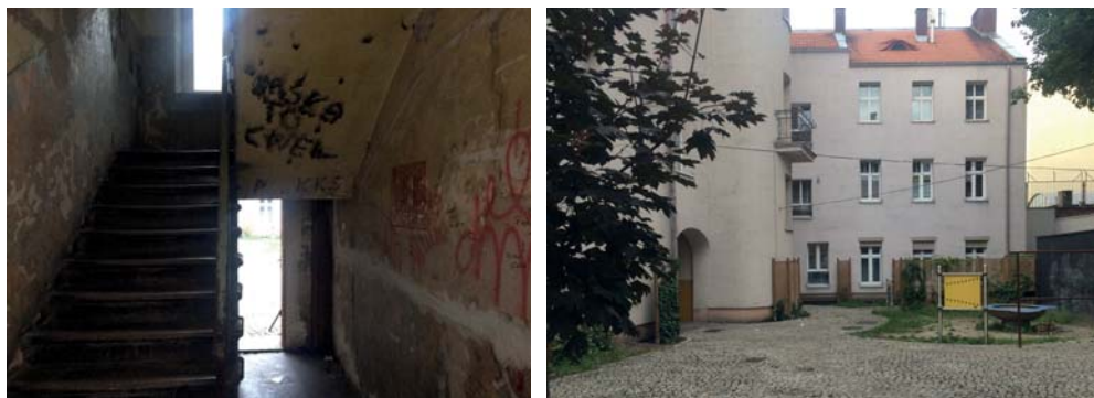
Ryc. 3. i 4. Klatka schodowa kamienicy przy ulicy Chodyńskiego prowadząca na „modelowe podwórko” oraz rzeczony podwórko po przebudowie, 2018. Fot. autora
