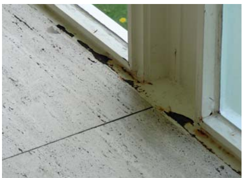
Ryc. 10. Ślady korozji elementów stalowych we wnętrzu
