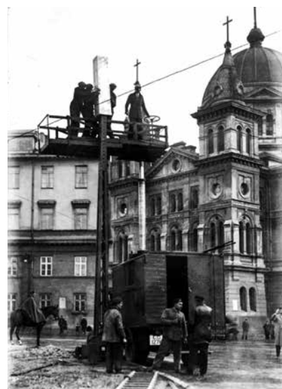
Fot. 2. Montaż lamp ulicznych na ulicach Łodzi (fot. Wiktor Jekimenko, źródło: Archiwum Veolia)
