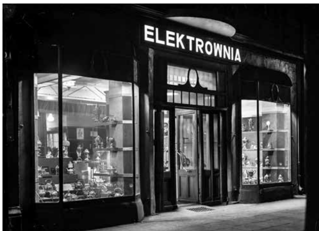
Fot. 4. Witryna sklepu Elektrowni Łódzkiej (fot. Wiktor Jekimenko, źródło: Archiwum Veolia)
