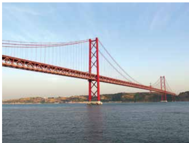
Fot.5. Most 25 Kwietnia nad Tagiem (fot. A. Danielewicz, A. Rosiak)
