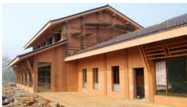
Rys. 2. Budynek wykonany z WPC [10]
