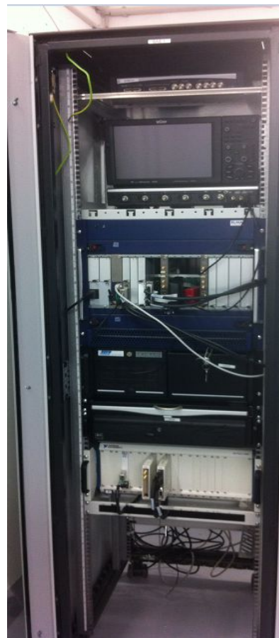
Rysunek 27 Zdjęcie systemu akwizycji obrazu w technologii MTCA.4 zbudowanego przez autora: kaseta w laboratorium CADAQ (rysunek a) oraz system zainstalowany w laboratorium w ośrodku ITER (rysunek b).
