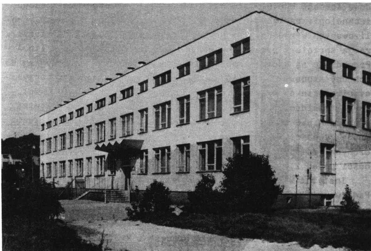
Budynek Międzyresortowego Instytutu Techniki Radiacyjnej (I-19)
