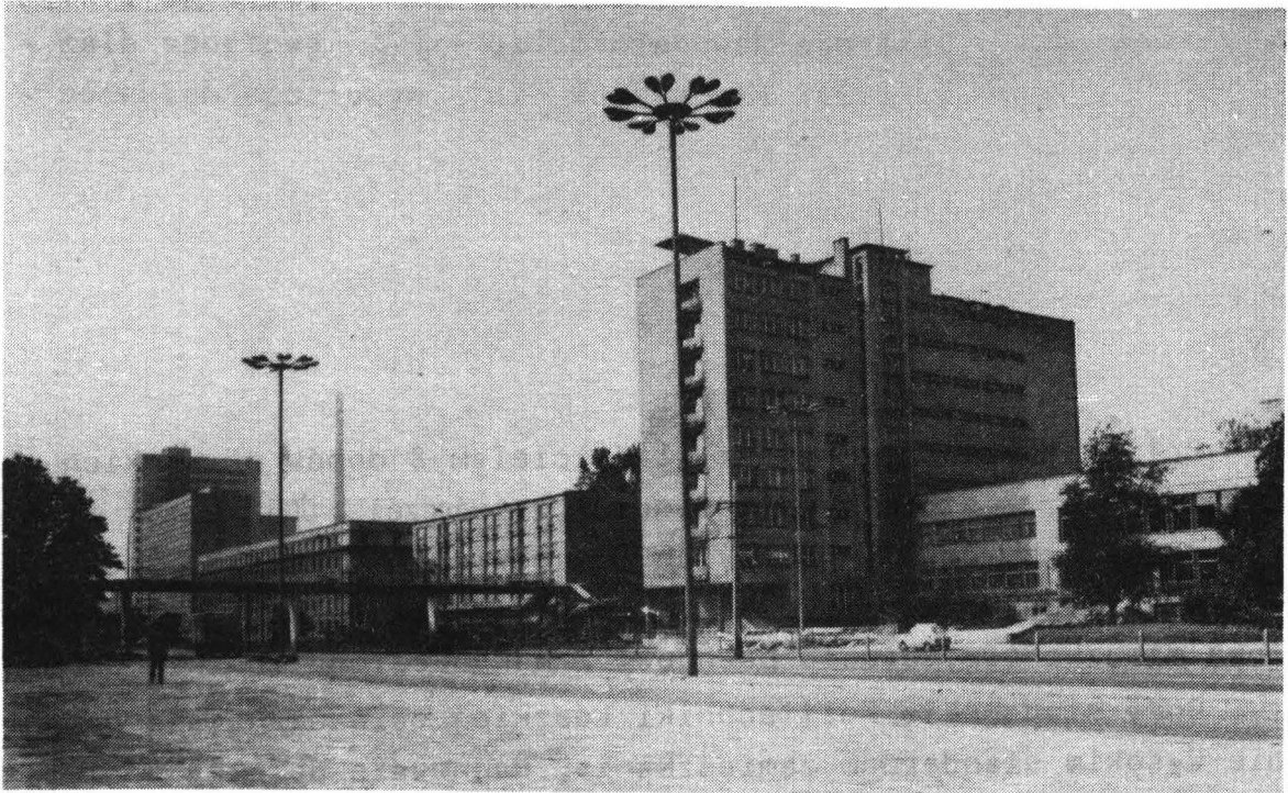
Osiedle akademickie - widok od strony północnej
