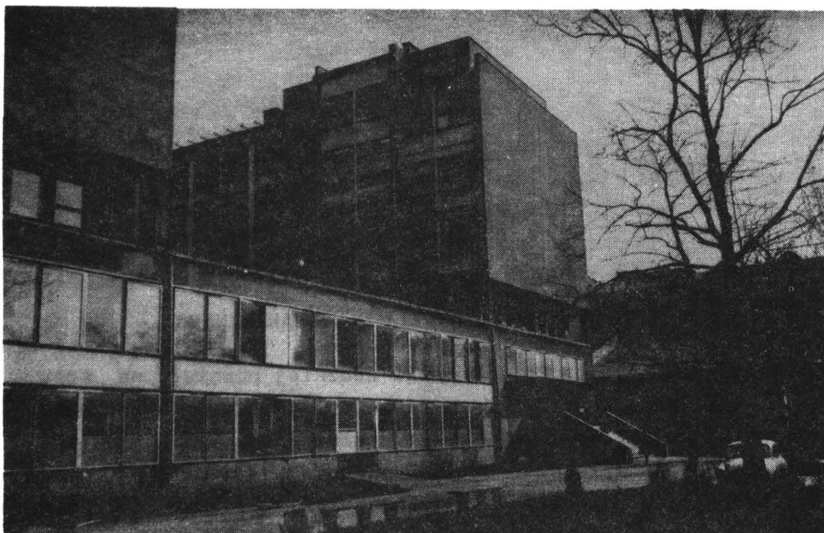
Gmach Wydziału Mechanicznego
