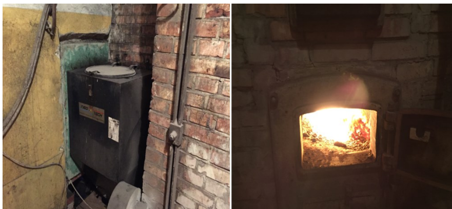
Rys. 2. Widok na kotłownię, po lewej zasobnik na ekogroszek, po prawej widok na główne palenisko pieca piekarniczego Źródło: opracowanie własne, marzec 2017.
