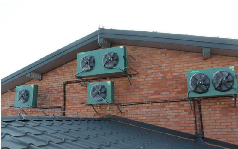
Rys. 12. Skraplacze wymienionych agregatów Bitzer umieszczone na zewnątrz zakładu
