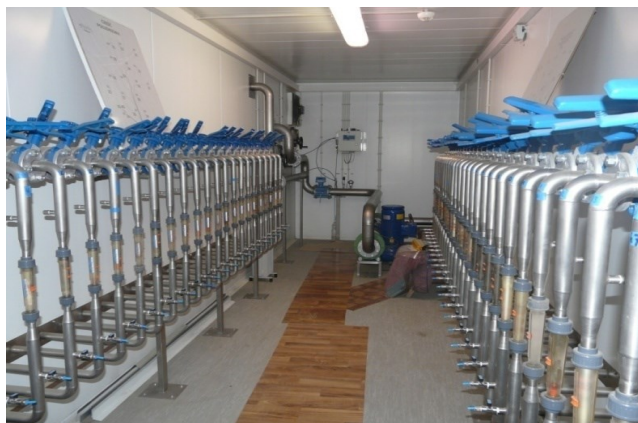
Rys. 5. Kontener stacji ssąco-tłoczącej
