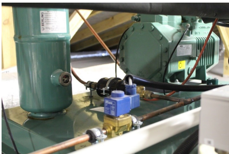
Rys. 11. Agregat chłodniczy Bitzer LH84, na zdjęciu sprężarka, zbiornik ciecchy, elektrozawór oraz filtr Źródło: opracowanie własne.
