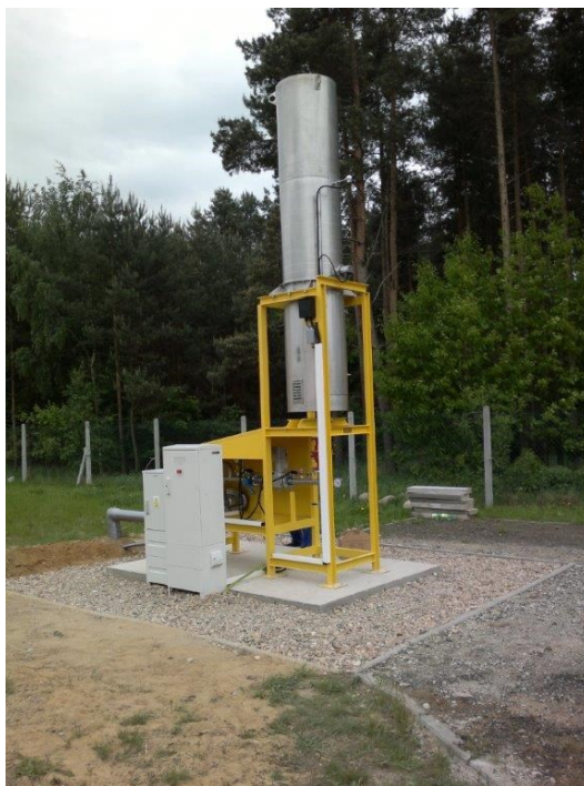
Rys. 7. Pochodnia do spalania biogazu
