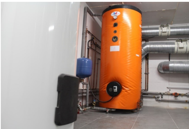
Rys. 6. Zbiornik wody zastosowany w odzysku ciepła w instalacji chłodniczej w zakładzie masarskim, instalacja zbudowana przez firmę Delta T
