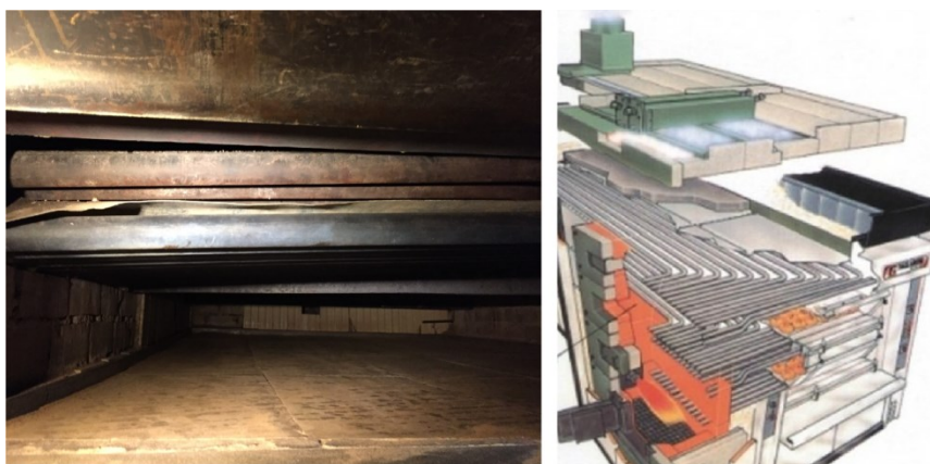
Rys. 3. Po lewej widok na komorę piekarniczą z rurami Perkinsa, po prawej schemat rozmieszczenia rur Perkinsa w piecu RRK 32 – widok bez zabudowy ceramicznej
