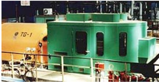
Rys. 12. Osłona akustyczna wzbudnicy generatora
