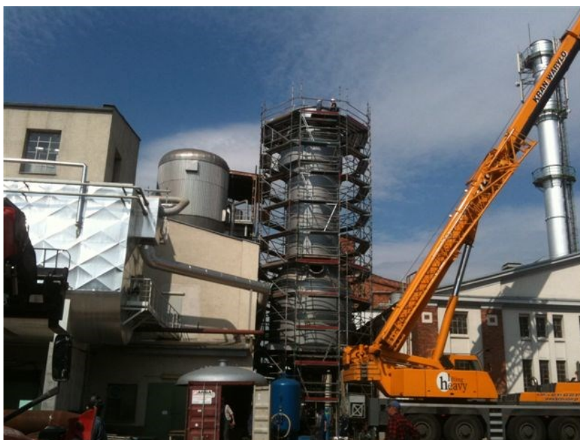
Rys. 1. Nowe rozwiązanie w produkcji cukru – ekstraktor wieżowy
