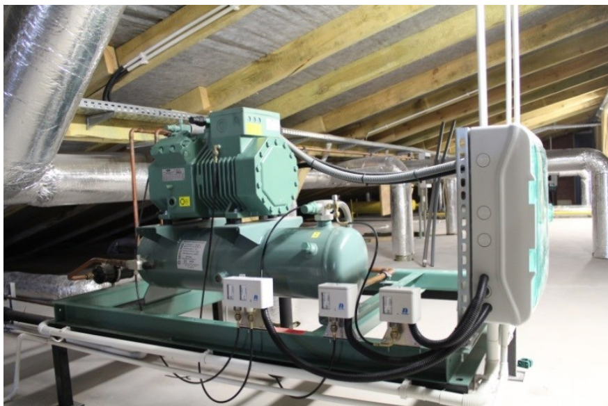
Rys. 10. Agregat chłodniczy Bitzer LH124, bez skraplacza Źródło: opracowanie własne.
