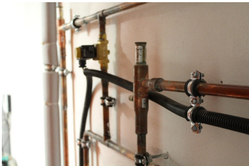
Rys. 13. Zawór KVR firmy Danfoss, w tle elektrozawór
