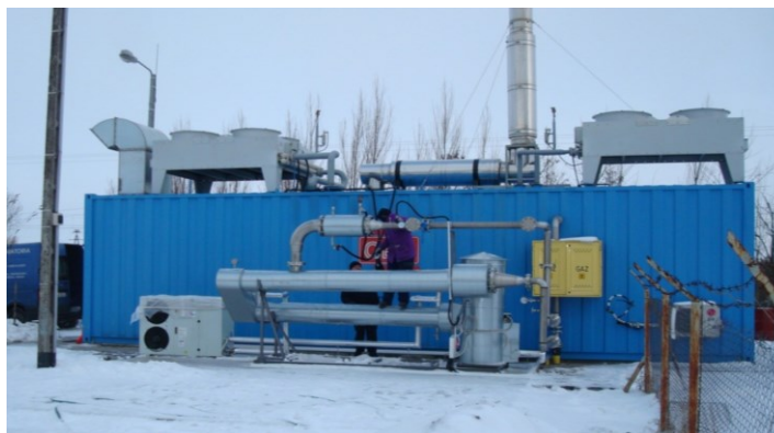
Rys. 8. Prototypowa instalacja osuszania biogazu zamontowana w elektrowni biogazowej
