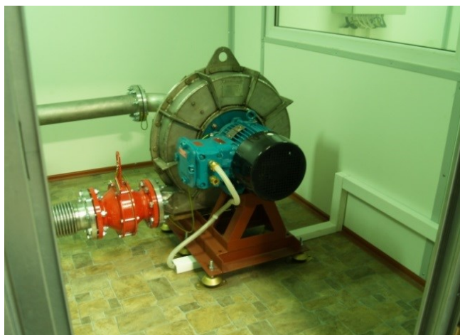
Rys. 6. Ssawa do biogazu
