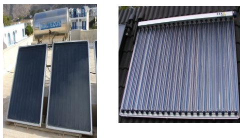
Rys. 7. Kolektor płaski ze zbiornikiem do ciepłej wody (a), kolektor próżniowy ze zwierciadłem doświetlającym (b)
