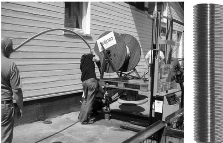
Rys. 5. Instalacja kolektora pionowego w postaci karbowanej rury ze stali nierdzewnej Fig. 5. Vertical collector installation in the form of corrugated stainless steel pipe
