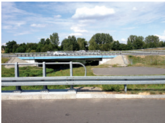
Rys.4. Bzura w pobliżu autostrady A2 (Fot. E. Skiba)
