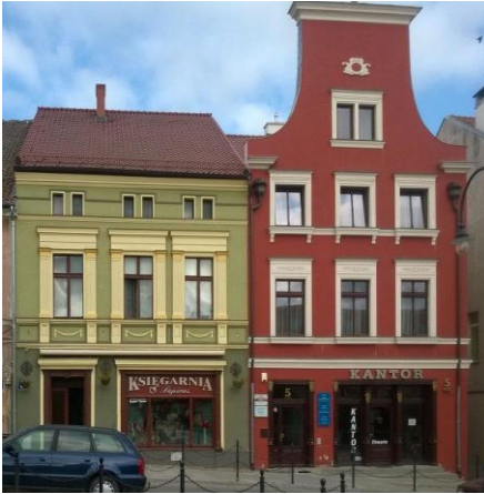
Fot. 23. Kamienice o estetycznej elewacji i stolarnie okiennej przy Placu Wolności
