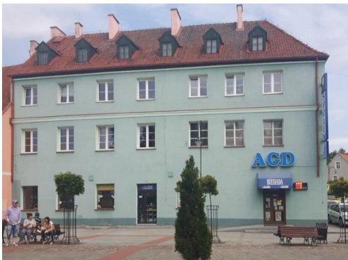
Fot. 32. Budynek przy ul. Powstańców Warszawy 4 z kontrastującą stolarką okienną
