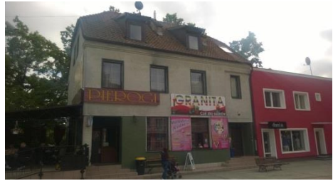
Fot. 2. Budynek mieszkalno-usługowy przy ul. Powstańców Warszawy 5
