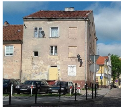
Fot. 33. Widok na budynek przy ul. Prostej 15 z niestetyczną ścianą
