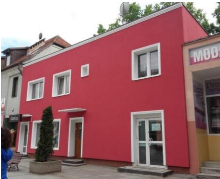
Fot. 26. Widok z ul. Powstańców Warszawy na budynek o zbyt intensywnym kolorze elewacji przy ul. Dębowej 1
