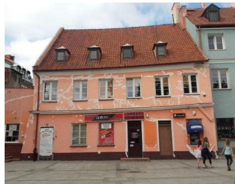
Fot. 27. Budynek przy ul. Powstańców Warszawy 4 z elewacją wymagającą remontu
