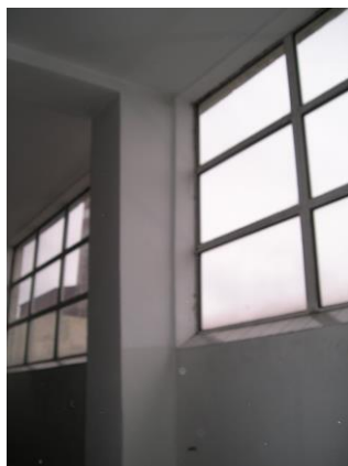
Rys. 2.7. Okna na hali produkcyjnej
