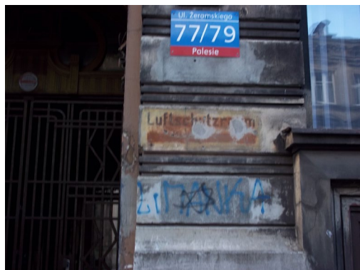
Zdj. 313. Napis Luftschutzraum – Żeromskiego 77/79, Łódź (archiwum autorki)
