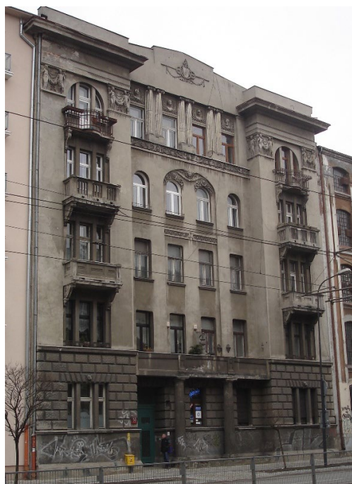
Zdj. 90. Fasada kamienicy – al. Kościuszki 53, Łódź (archiwum autorki)
