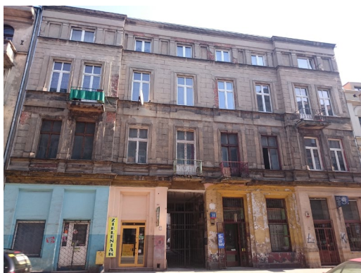
Zdj. 74. Elewacja Kamienicy – Wschodnia 38, Łódź (archiwum autorki)
