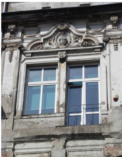
Zdj. 153. Okno – Tuwima 6, Łódź (archiwum autorki)
