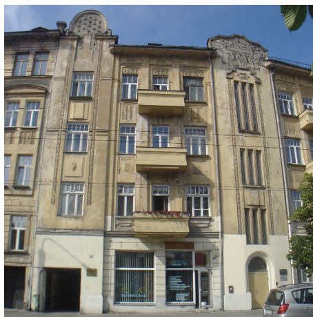
Zdj. 46. Kamienica przy ul. Pamenkalnio 28, Wilno (archiwum autorki)
