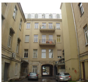
Zdj. 389. Elewacja tylna – podwórze Al. Giedymina 22, Wilno (archiwum autorki)
