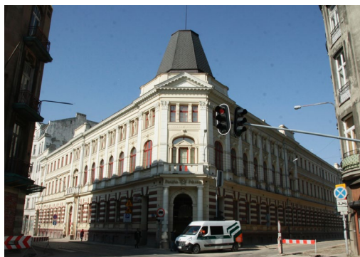
Zdj. 26. Budynek Poczty Głównej – Tuwima 38, Łódź (archiwum autorki)
