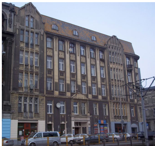
Zdj. 91. Fasada kamienicy – Narutowicza 44, Łódź (archiwum autorki)
