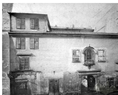
Zdj. 109a. Fasada kamienicy – Grodzkich 3 (XVIIIw.) Lwów (zdjęcie archiwalne, LMH, Fm. 613)
