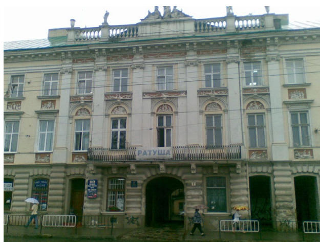
Zdj. 9. Kamienica Pillerów – Wynnyczyńki 8, Lwów (archiwum autorki, 2013 rok)
