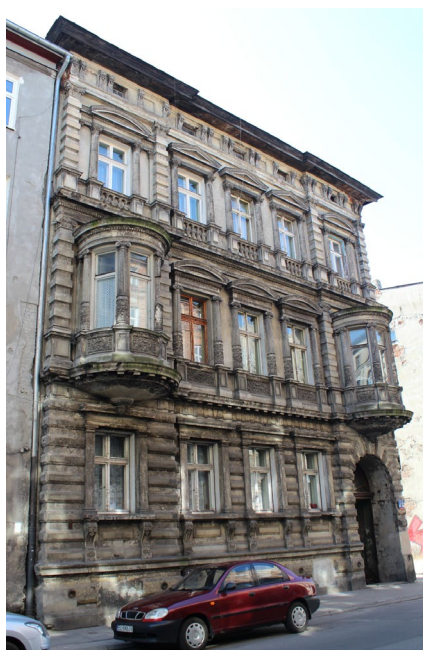
Zdj. 76. Elewacja kamienicy – Włókienicza 11, Łódź (archiwum autorki)
