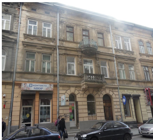
Zdj. 114. Fasada kamienicy – Piekarska 6, Lwów (archiwum autorki)
