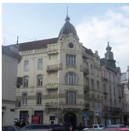
Zdj. 122. Fasada kamienicy – Czajkowskiego 6, Lwów (archiwum autorki)
