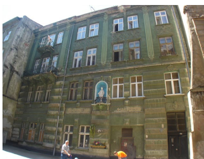
Zdj. 109. Fasada kamienicy – Drukarska 3, Lwów (archiwum autorki)
