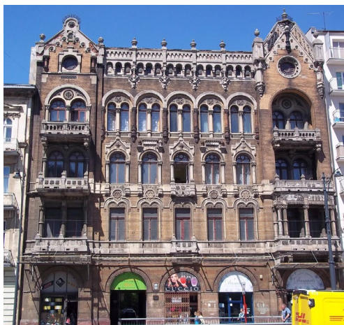
Zdj. 214. Fasada kamienicy – Narutowicza 32, Łódź (archiwum autorki)
