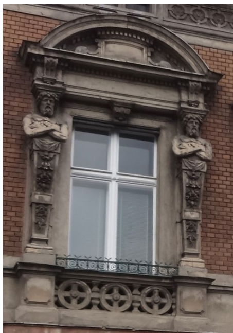
Zdj. 154. Okno – Nawrot 30, Łódź (archiwum autorki)
