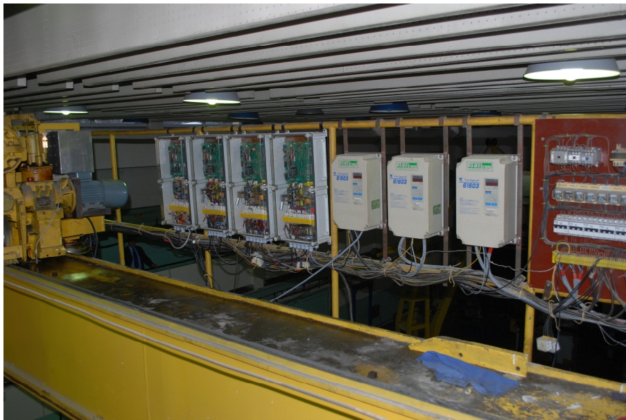
Fot. 5.3. Układ sterowania suwnicy eksperymentalnej
