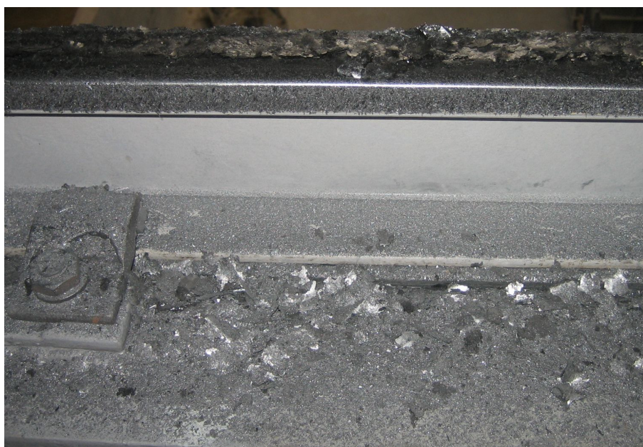
Fot. 6.3. Zniszczenie szyny
