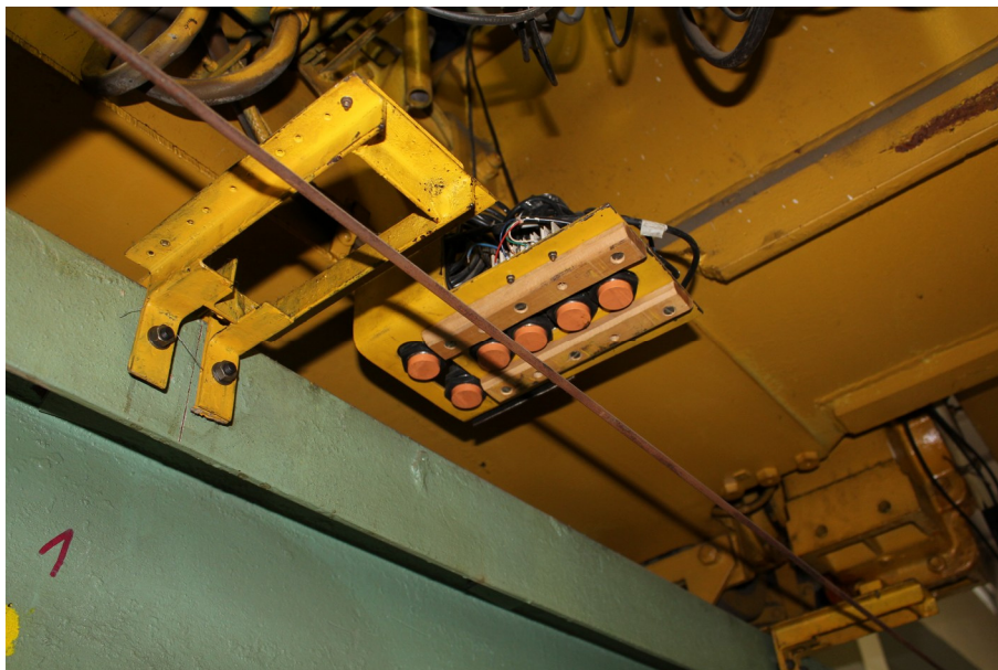
Fot. 5.6. Zestaw czujników korekcji położenia prawej czołownicy
